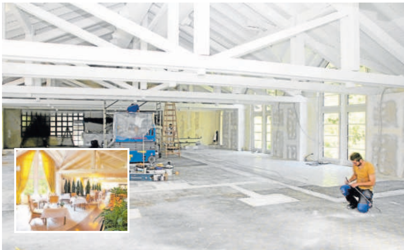
Das Restaurant „Boulevard“ vor (kl. Bild) und während der Renovierung. Hier entstand ein modernes Buffet-Restaurant.
