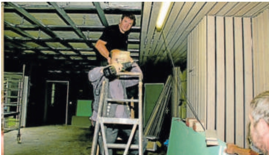
2013 wurde der Wellnessbereich großflächig umgebaut.
